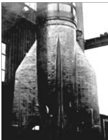
Установка БРДД Р-2 в стенд
