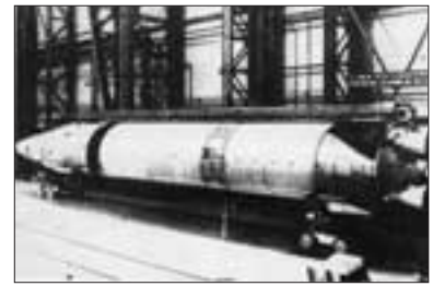
Р-9 в монтажно-испытательном корпусе
