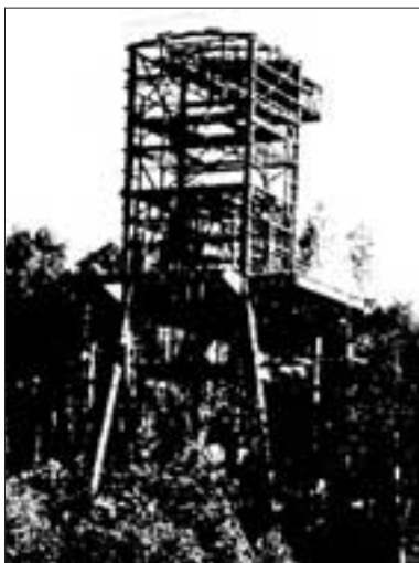
Начало строительства объекта №1
